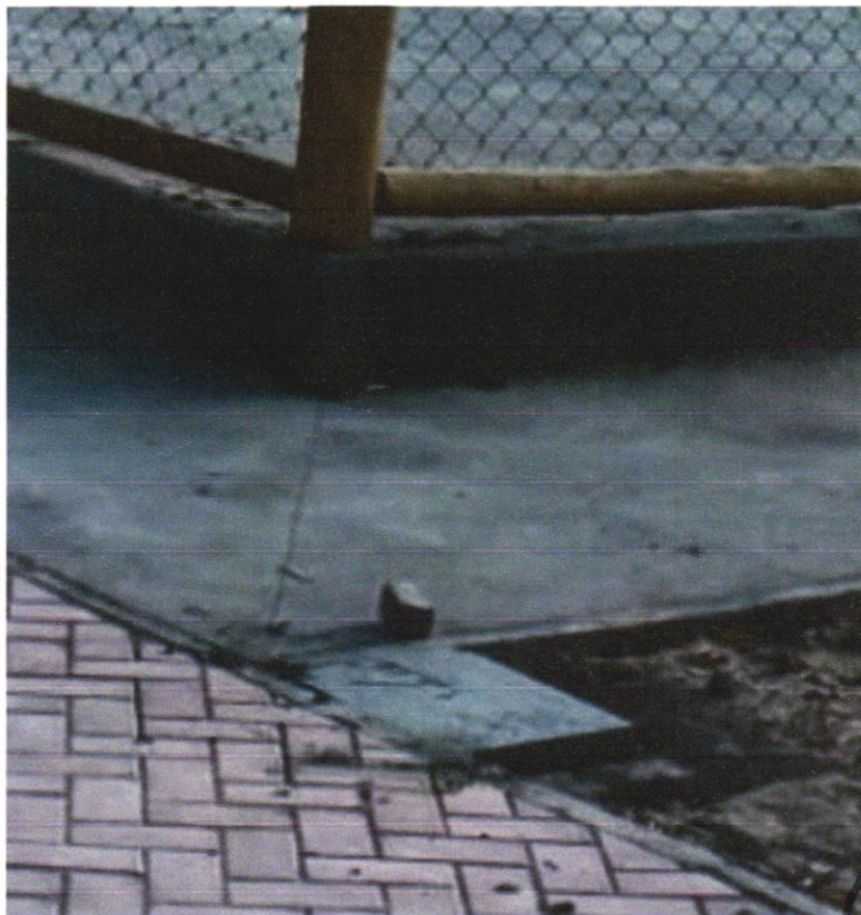
FOTO 04: CAIXA ENTERRADA ELÉTRICA RETANGULAR, EM ALVENARIA COM TIJOLOS CERÂMICOS MACIÇOS, FUNDO COM BRITA, DIMENSÕES INTERNAS: 0,3X0,3X0,3 M. AF 12/2020
