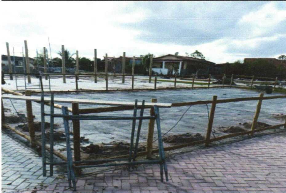
FOTO 05: FORNECIMENTO E MONTAGEM DE CERCA DE PROTEÇÃO EM EUCALIPTO CLOEZIANA TRATADO A BASE DE CCA EM AUTOCLAVE, COM APLICAÇÃO DE STAIN NA COR NATURAL COM DUPLO FILTRO SOLAR, DIAMETRO DO EUCALIPTO DE 6 A 8 CM, COM ANTI-RACHA NA EXTREMIDADE. FECHAMENTO COM TELA DE ALAMBRADO FIO Nº 12 REVESTIDO DE PVC, MALHA 2.1/2 X 2.1/2", FIXADO COM FIO Nº 14 REVESTIDO EM PVC, MÓDULO MEDINDO 1,50 X 1,00M , PARAFUSOS GALVANIZADOS COM TRAVAMENTO CLICKFIX,
