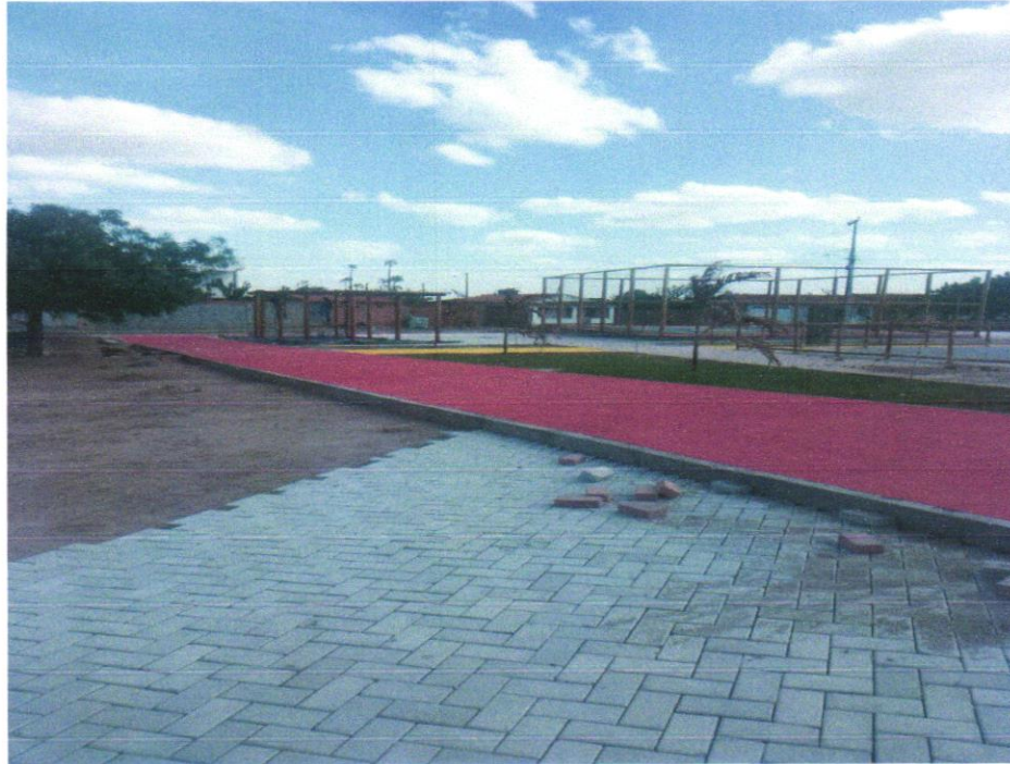
FOTO 07: Pavimentação em bloco de concreto vibroprensado, intertravado, cor natural, 0x20cm, e=6cm, 46un/m 2 , NBR9781, Fck(min)=35MPa, sob coxim areia grossa compactada c/ placa vibratória, e(comp.)=6cm, rejuntado c/ areia fina.
