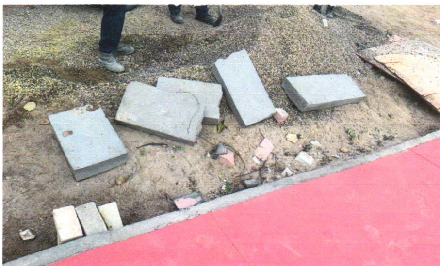
FOTO 1: RETIRADA DE MEIO-FIO DNER / ECONOMICO COM EMPILHAMENTO E SEM BOTA FORA
