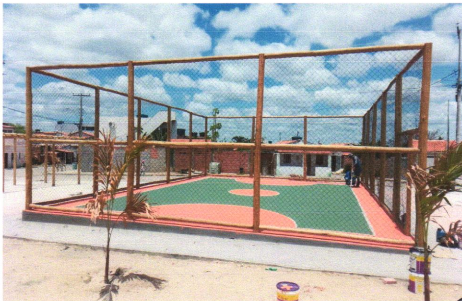
FOTO 06: PINTURA DE PROTEÇÃO SOBRE MADEIRA, COM 02 DEMÃOS, VERNIZ POLISTEN - STAIN, AÇÃO FUNGICIDA E INSETICIDA, COR TRANSPARENTE, SAYENBLASKIUS SIMILAR
