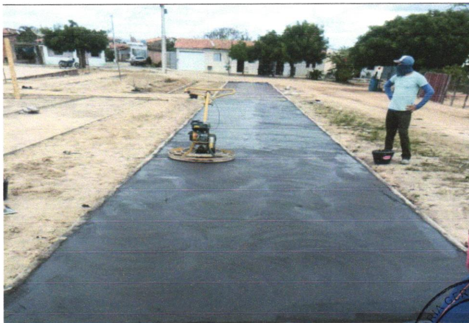
FOTO 08: ACABAMENTO POLIDO PARA PISO DE CONCRETO ARMADO DE ALTA RESISTÊNCIA. AF_09/2017
